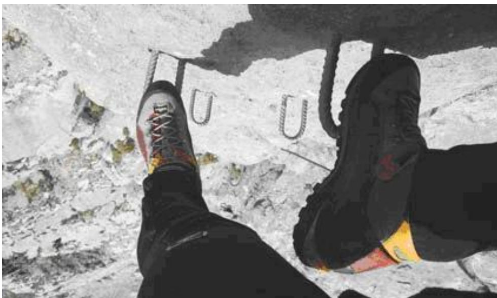
Slika 27: »U« stopa, preprosta in učinkovita. Pozor, zadostiti mora normativom trdnosti predpisanim za fiksne točke (samovarovanje).
