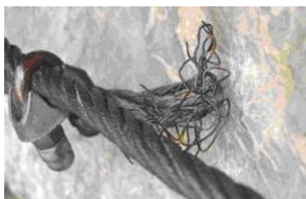
Slika 28: Poškodovana jeklena vrv
