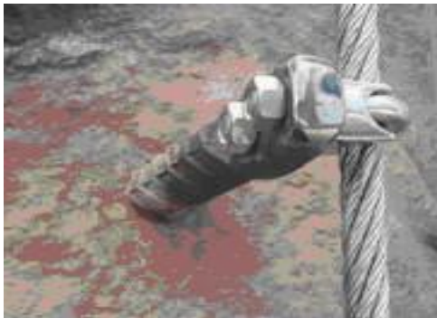
Slika 34: masivno, ploščato-kovano sidro namenjeno prečnim obremenitvam
