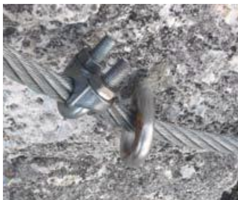
Slika 38: spojka jeklene vrvi pred in po očesu vmesnega sidra ni pripročljiva
