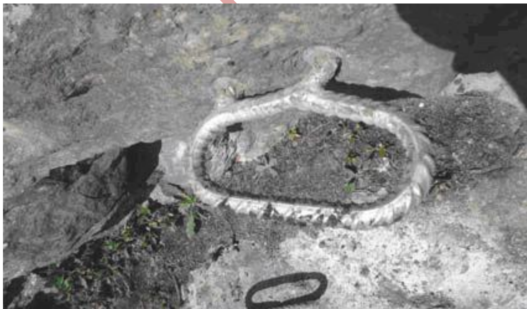
Slika 26: Stopno krožno pomagalo iz obstojnega jekla (vroče cinkano) ne vsebuje ostrih robov. V primeru stopanja na rob ne pride do zasuca pomagala.
