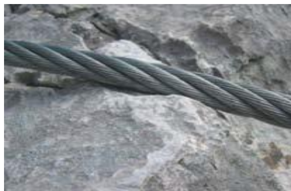
Slika 50: jeklena vrv se drgne ob skalo in se kmalu poškoduje.
