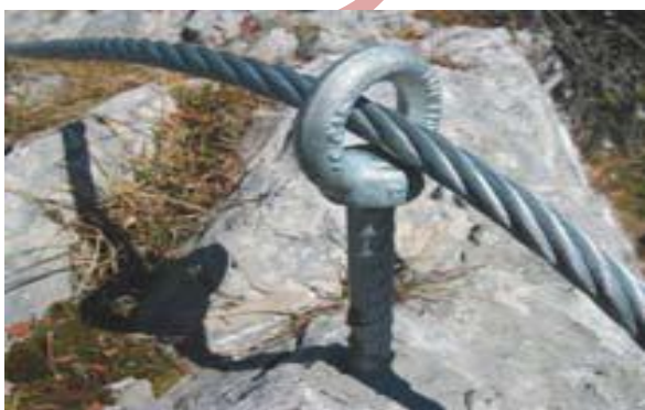
Slika 49: Obročne matice nimajo prečne nosilnosti
