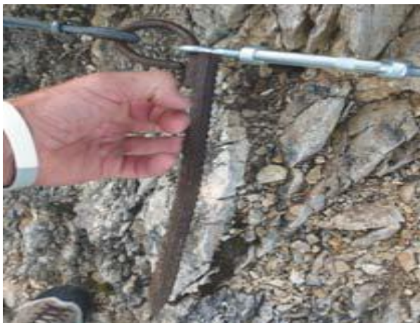
Slika 43: Krpanje v sistemu varoval je lahko nevarno
