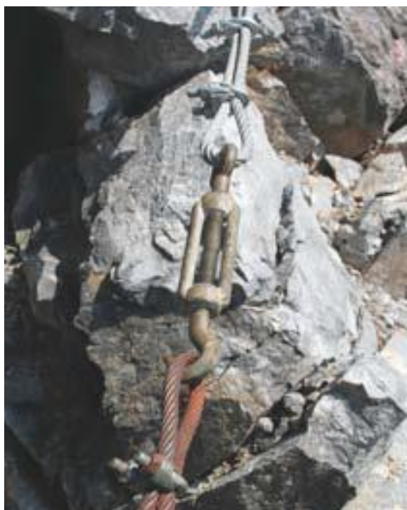
Slika 51: odprt napenjalni sistem v varovalni verigi
