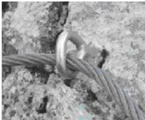
Slika 42: pretanka jeklena vrv; premalo spojk za jekleno vrv, zanka jeklene vrvi brez notranjega vložka; standardni svedrovci so sicer dovoljeni, vendar bi bilo pravo sidro veliko bolj primerno.
