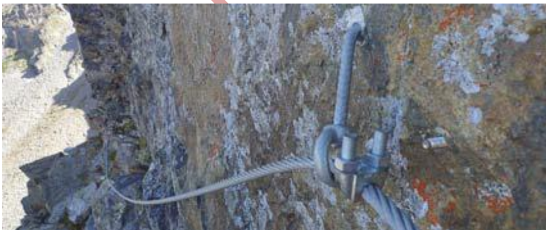
Slika 37: glej komentar pod sliko 36. Dolžina in debelina sidra kot način pritrdjevanja so neustrezni.
